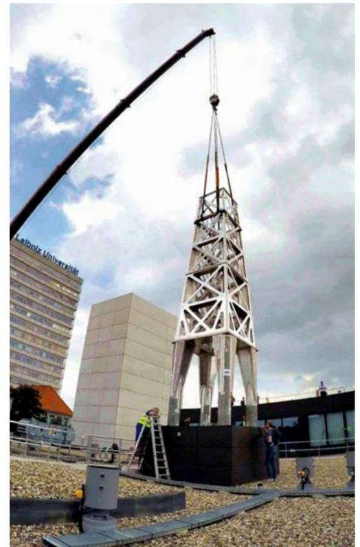
Das entstehende Atominterferometer an der Universität Hannover: Installation des Haltegerüsts für die sogenannte VLBAI-Versuchskammer
